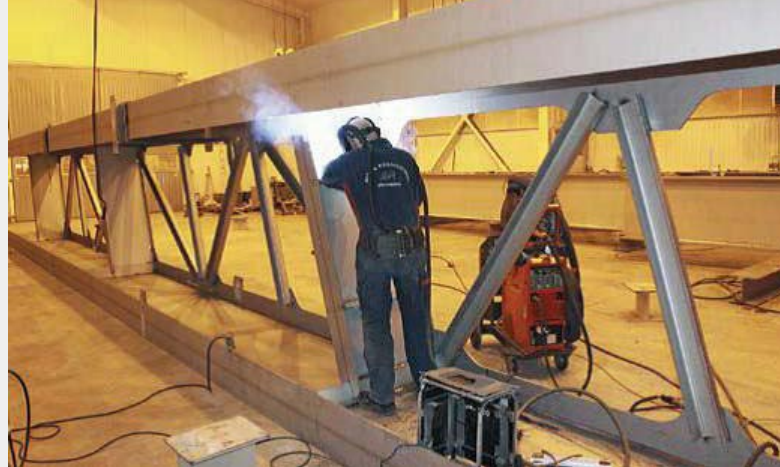
▲ Obr. 3 Ocelový nosník železničního mostu ve Stockholmu během výroby – vlevo a při montáži – vpravo (foto: Lars Hamrebjörk)
