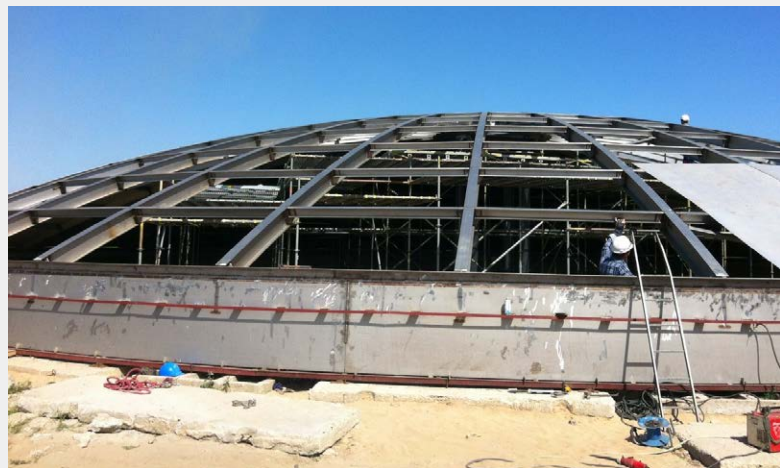
▲ Obr. 4. Laserem svařované průřezy použité pro konstrukci střechy továrny na výrobu hnojiv v Polsku (foto: Montanstahl)
