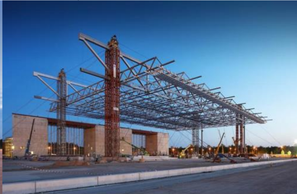
A380-Halle, Anhebung des Hallendaches in Frankfurt
