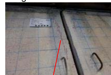
Longitudinal cracks
